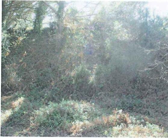
PARAPETO ZONA NORTE
